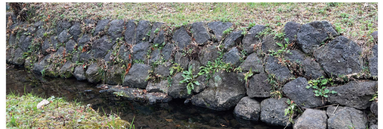
例：溶岩を利用した擁壁
