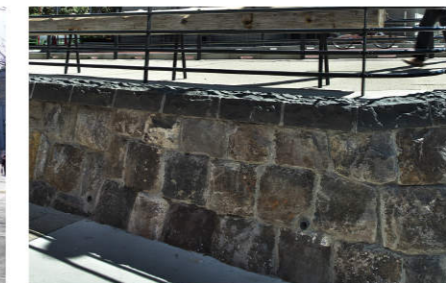
○ 良い例：現場で出た石材の再利用
