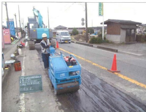
仮舗装施工状況
