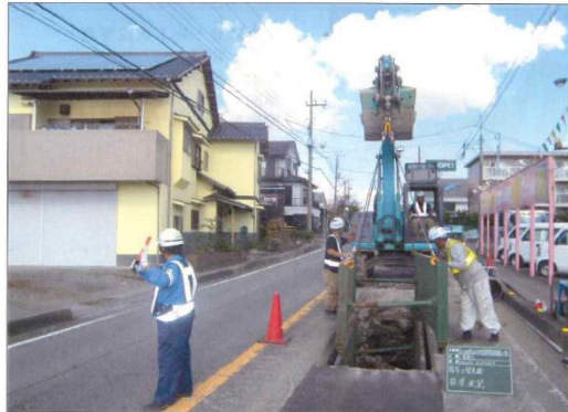
簡易土留設置状況
