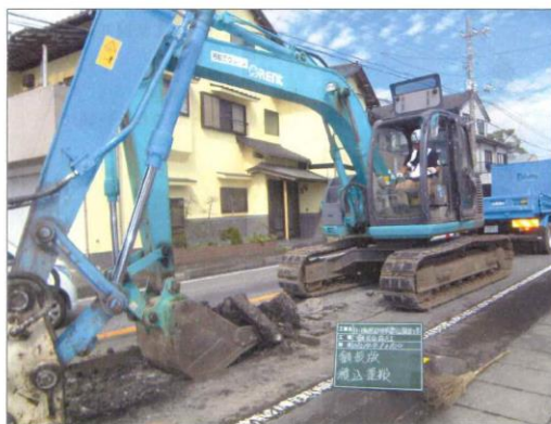
舗装取壊し状況
