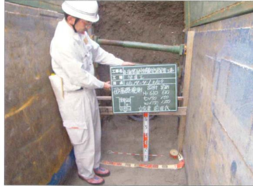
砂基礎施工状況 再生砂
