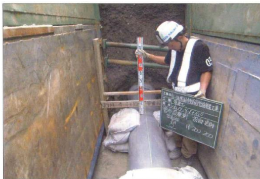
管渠布設状況 VU \phi 400mm
