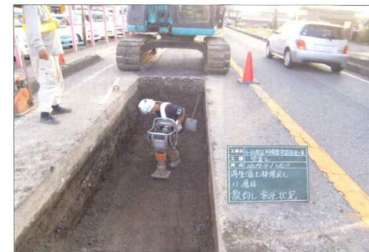
埋戻し転圧状況 再生盛土材 タンパ転圧1層20cm
