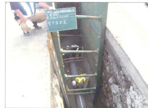
配管作業状況 VU \phi 400mm
