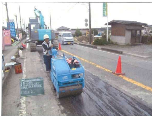
仮舗装施工状況
