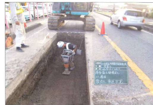
埋戻し転圧状況 再生盛土材 タンパ転圧1層20cm
