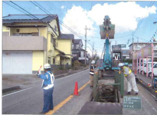
簡易土留設置状況
