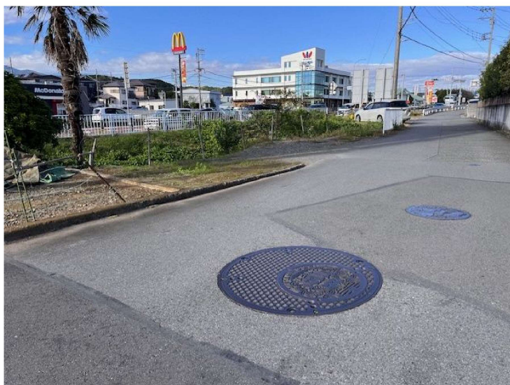
マンホールポンプが入ったマンホール マンホールの深さは約 8 m
