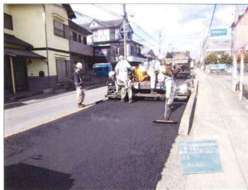
舗装本復旧施工状況
