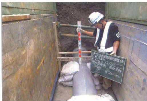
管渠布設状況 VU \phi 400mm
