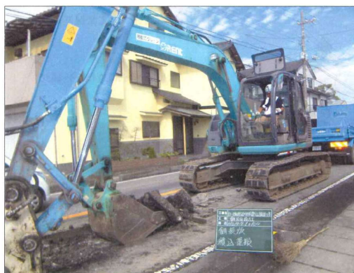
舗装取壊し状況
