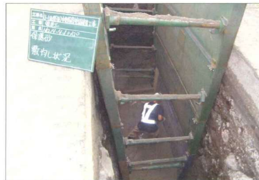
土留工（簡易土留）
