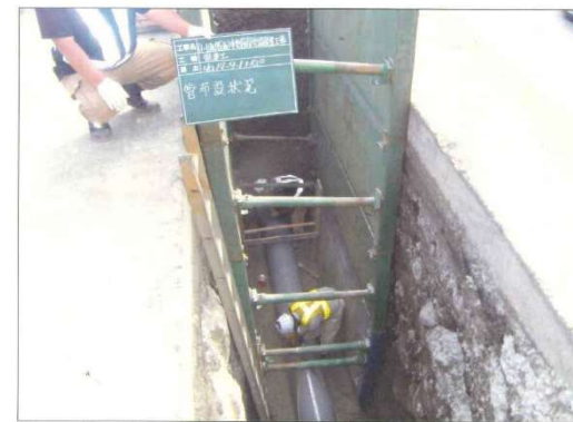
配管作業状況 VU \phi 400mm
