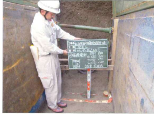
砂基礎施工状況 再生砂
