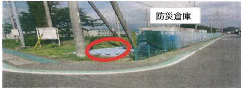
御殿場線沿い南小防災倉庫
