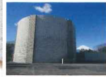
石脇配水場 5,000m 3
