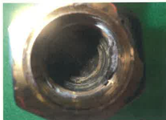
No.13 口径内部 (写真-5)
