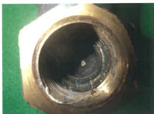
No.9 口径内部 (写真-4)
