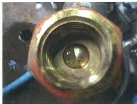
No.6 口径内部 (写真-7)
