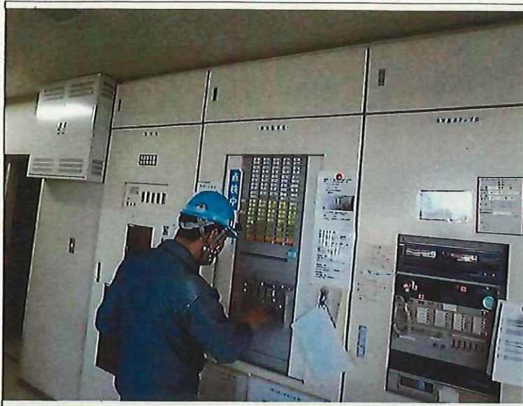
令和2年度 市単事業 裾野市民文化センター ホール棟 スプリンクラー設備 修繕工事
