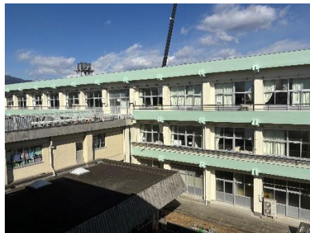
北校舎の外壁改修
