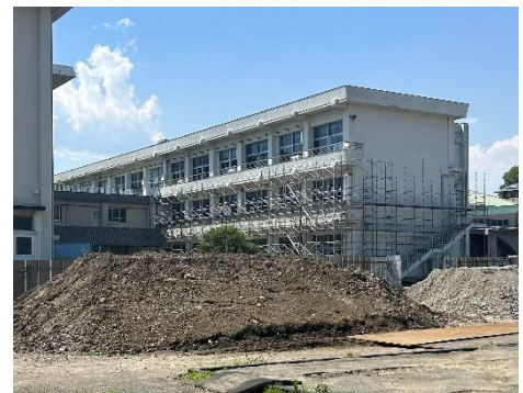
外壁&わくわく広場 工事中
