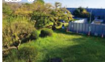
せせらぎ児童公園と解体中の市営プール
