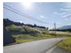
荒造成のみが完了している市営墓地第2工区
