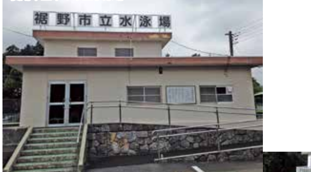
使用中中止中の市立水泳場
