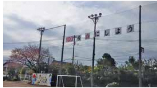
◀東小照明設備
