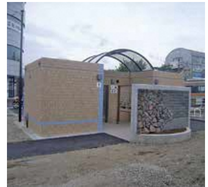
裾野駅西口トイレ
