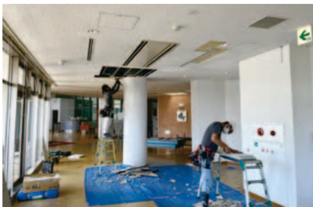
リニューアルに向けて工事中のヘルシーパーク
