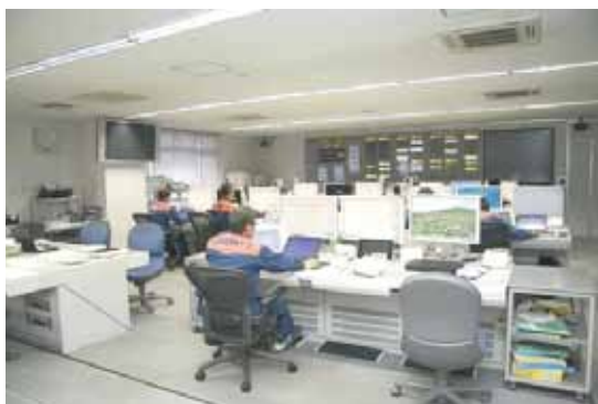
▲高機能消防指令システム
