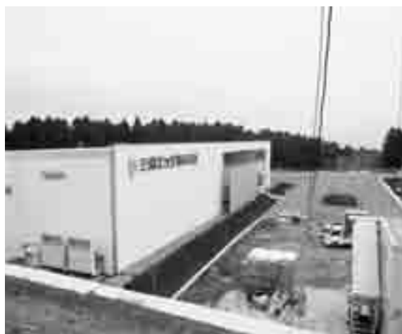
工場棟の建設が進む新富士裾野工業団地（須山）
