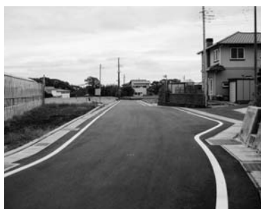
市道1366号線 道路拡幅(深良)
