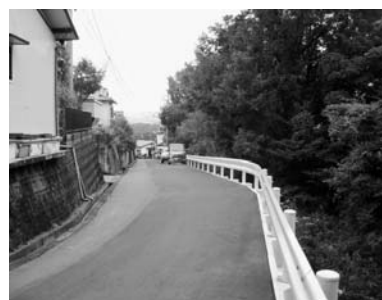
市道2093号線 ガードレール設置(桃園)
