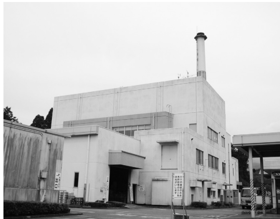
延命化工事を実施（美化センター）
