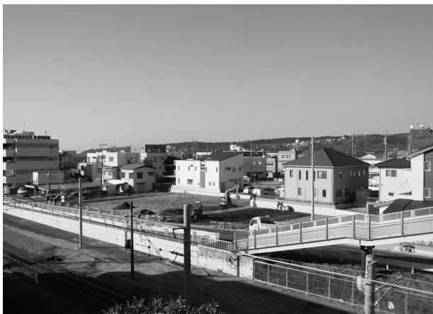
工事中の駅西區画整理地内（平松）
