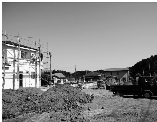
建設が進む呼子地区
