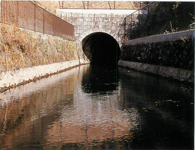
3 深良用水隧道出口(穴口)
