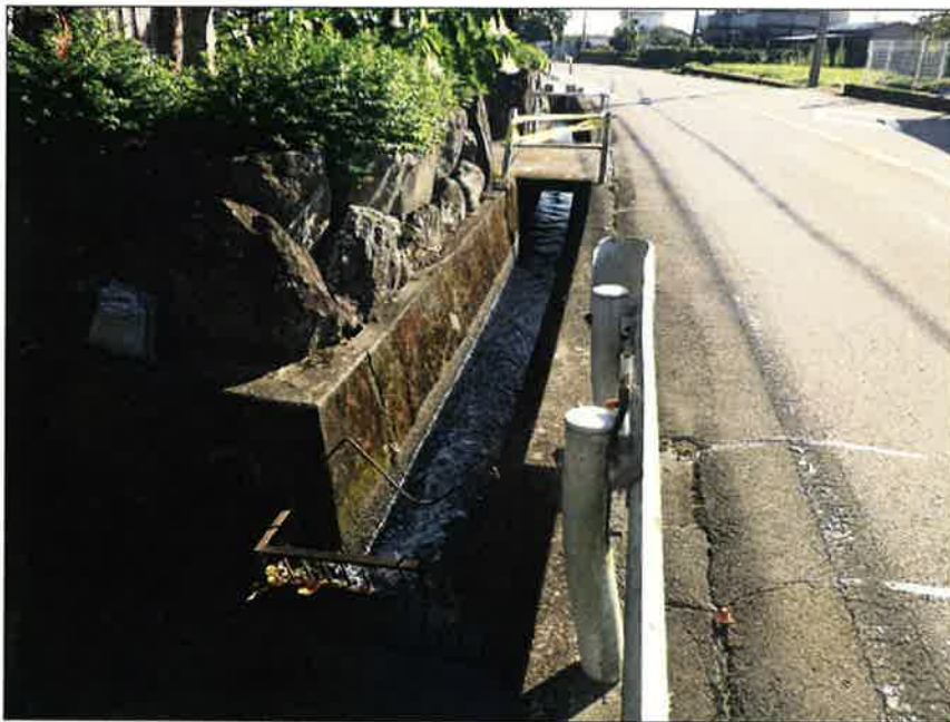
写真区分:着手前・完成 工種:着手前
