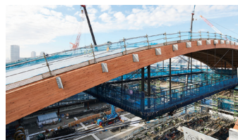
約90mの梁(はり)は、国産のカラマツ集成材に職人の手を入れながら製作。
