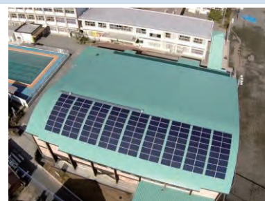
西小学校体育館の太陽光発電
