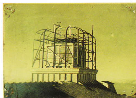
剣ヶ峰観測所に建築中の測風塔
