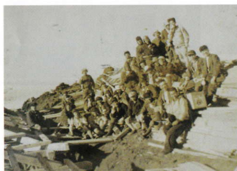
剣ヶ峰での観測所の建設
