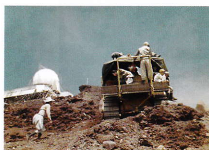
山頂へ建設中のドームが見える
