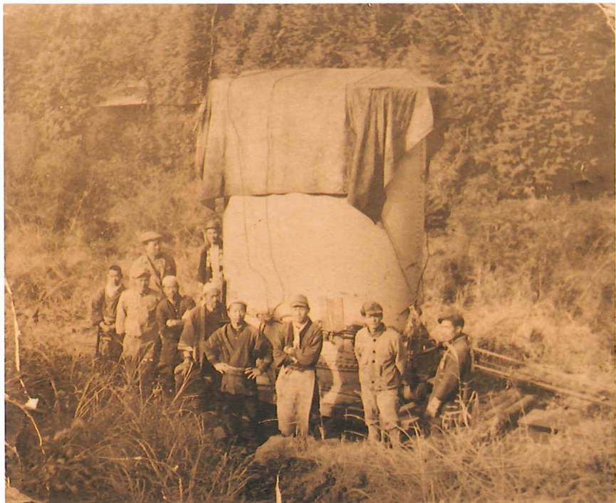
変圧器の運搬 ～深良川第一発電所～ (深良 小林秀年家蔵)
