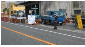
工事箇所写真 F
