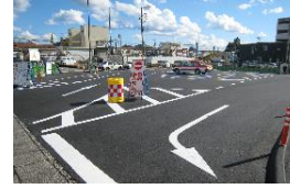
工事箇所写真 A
