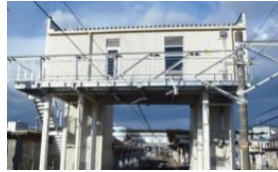
工事箇所写真 B
