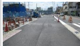
工事箇所写真 D
