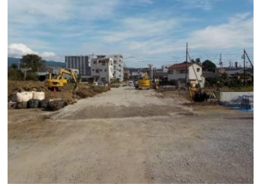
<施工中① 令和 2 年 11 月>
