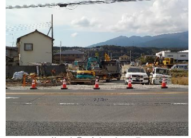
<施工中② 令和 2 年 11 月>
