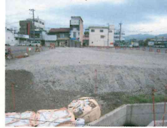
工事箇所写真①(完成)
