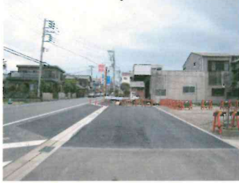
工事箇所写真②(完成)
