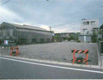
工事箇所写真③(完成)
