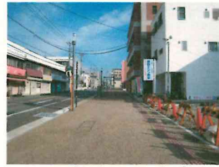
工事箇所写真①
