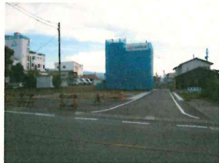
工事箇所写真②
