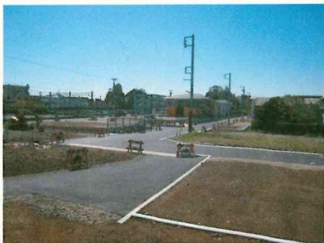
15,16,17街区周辺写真
