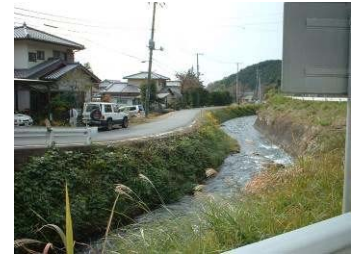
深良川（新深良橋下流）
