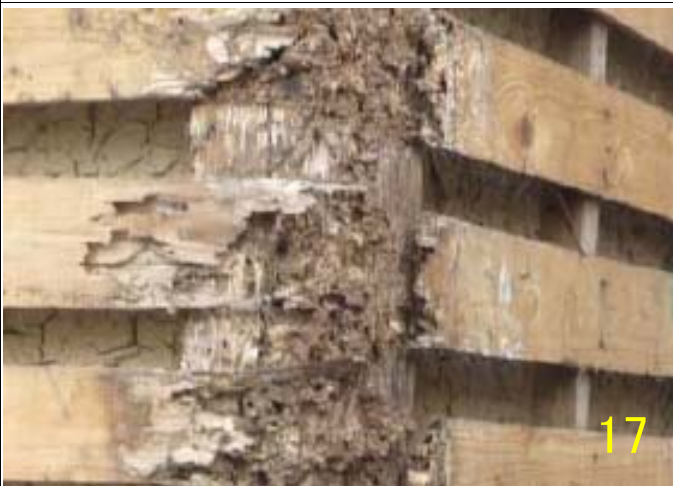
L 2 柱の著しい腐朽（多数の場合 L 3）
