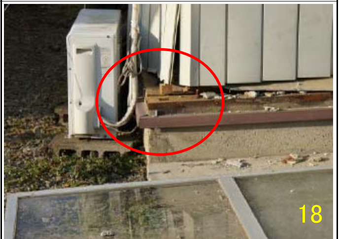
L 2 柱の抜け出し（多数の場合 L 3）
