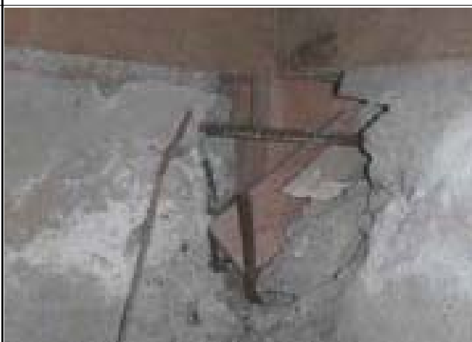
L 2 基礎のモルタルの剥離 (広範囲にわたる場合 L 3)
