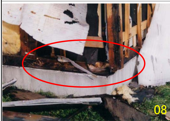
L 2 土台の著しい腐朽、損傷 (広範囲にわたる場合 L 3)
