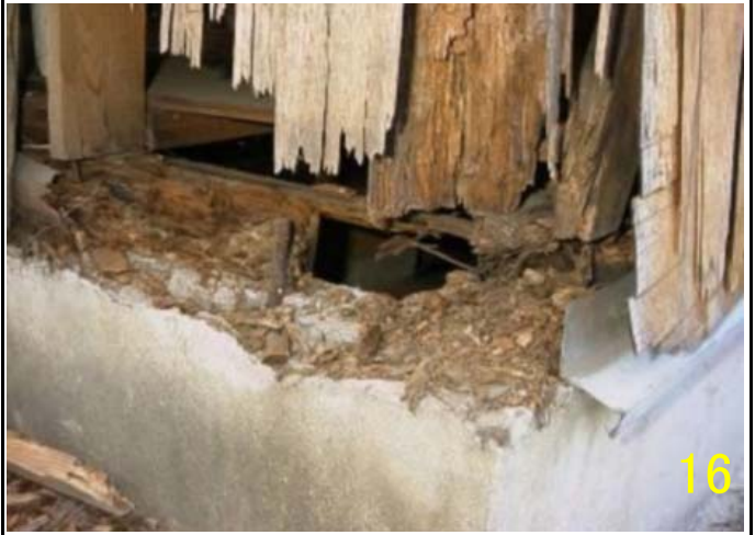
L 2 柱の抜け出し（多数の場合 L 3）
