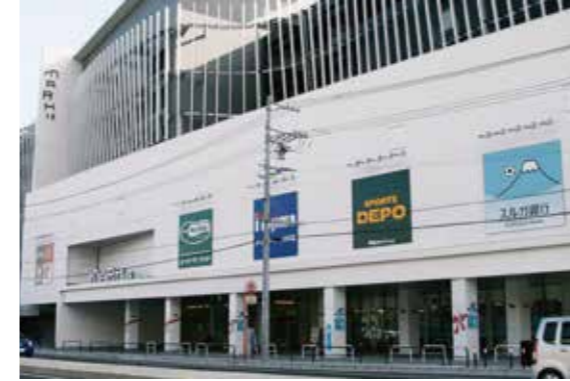
建物に設置されている高さや大きさの統一された複数の広告物(静岡市)
