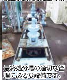
浸出水設備汚泥掻き寄せ機
