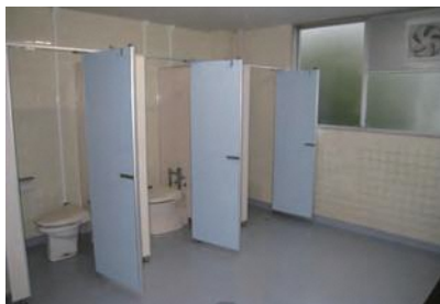
学校トイレ洋式化改修
