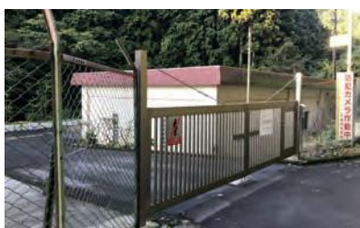
市街化区域内にあるコミュニティプラント
