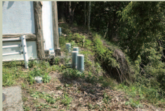
閉鎖時、崩落した地盤の様子
