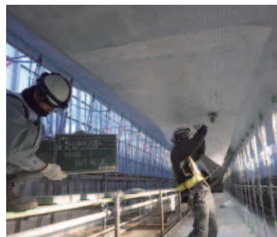
東名跨道橋補修工事
