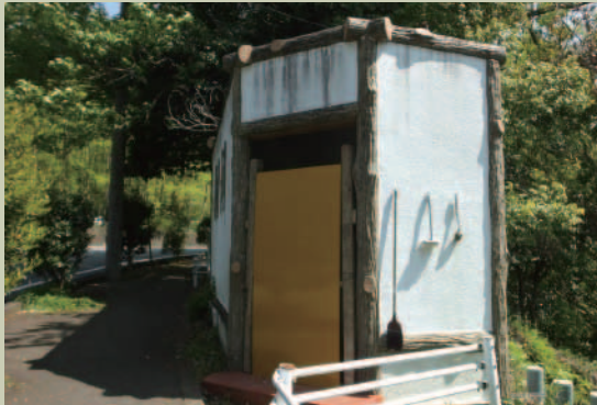
撤去されたトイレ
