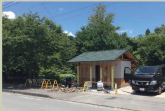
建設中の景ヶ島公園公衆用トイレ
