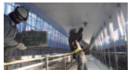
跨道橋の工事
