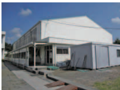
富岡第二小学校体育館
