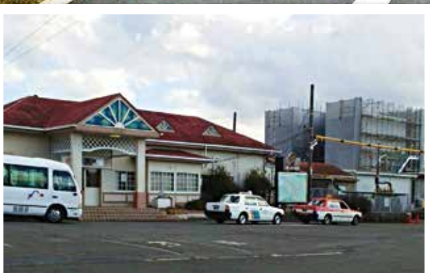
裾野駅と建設中のエレベーター(右)
