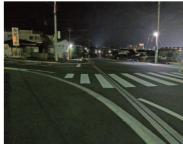
御宿台社宅入口交差点の道路照明灯
