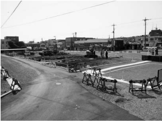
施工中の区画整理（平松）
