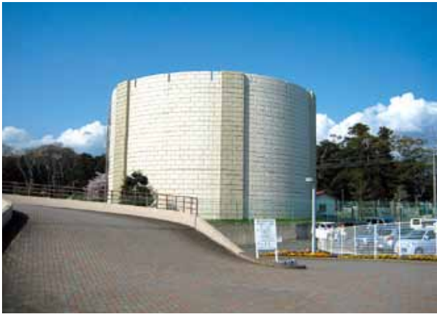
安定的な供給が求められる水道事業（石脇配水場）
