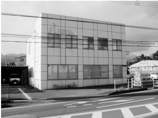
水道部が移転予定の元労金建物（深良）
