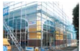
建設中の富岳裾野学園（石脇）
