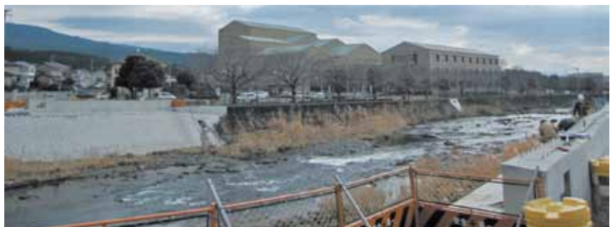
市道2-29号線 工事中の柳端橋
