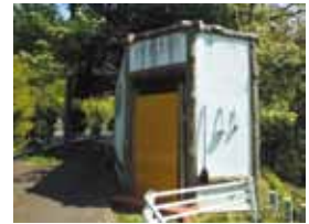
撤去前の景ヶ島のトイレ
