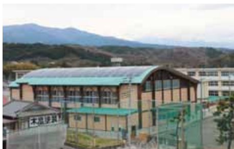
設置された太陽光パネル
