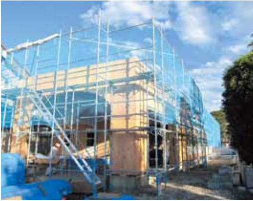
建設中の富岳裾野学園（石脇）
