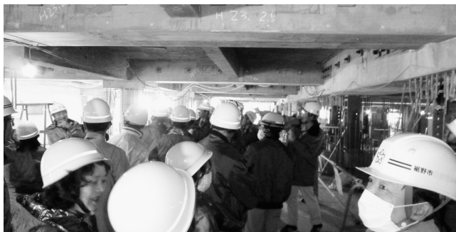
市庁舎地下1階の視察
