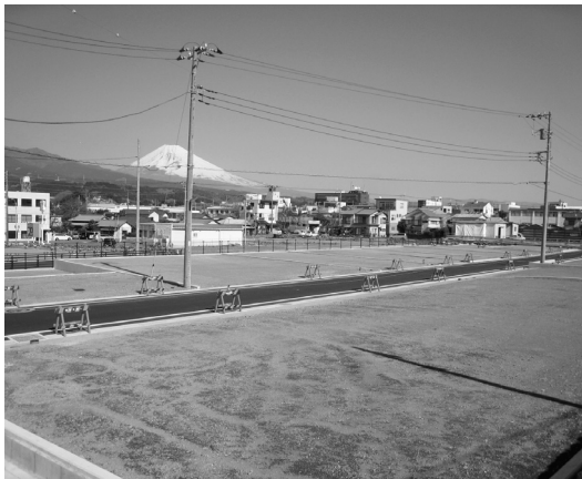
施工中の区画整理（平松）
