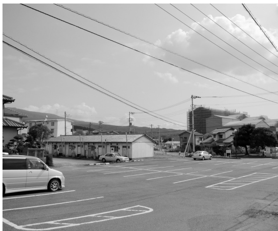
柳端団地と工事中の改良道路
