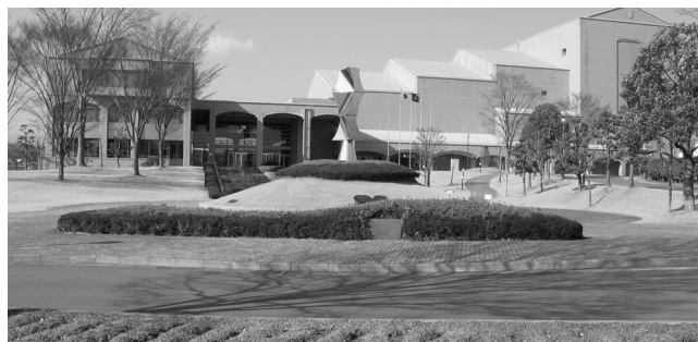
外壁の修繕を行う市民文化センター
