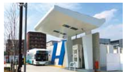
水素ステーション
