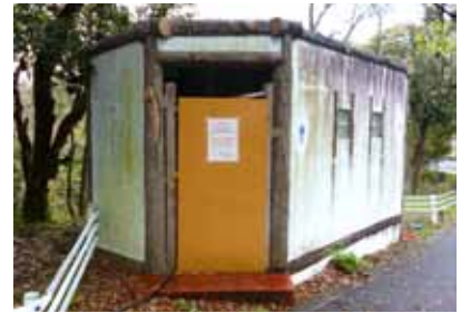
使用中止中の景ヶ島公園トイレ
