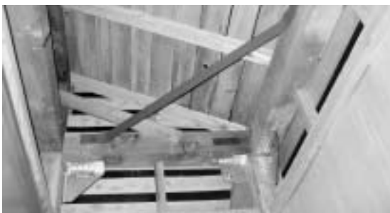
耐震診断による改築例
